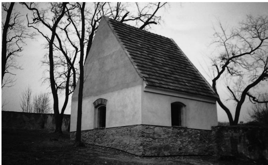
Nově zrekonstruovaná márnice v Prčicích.
