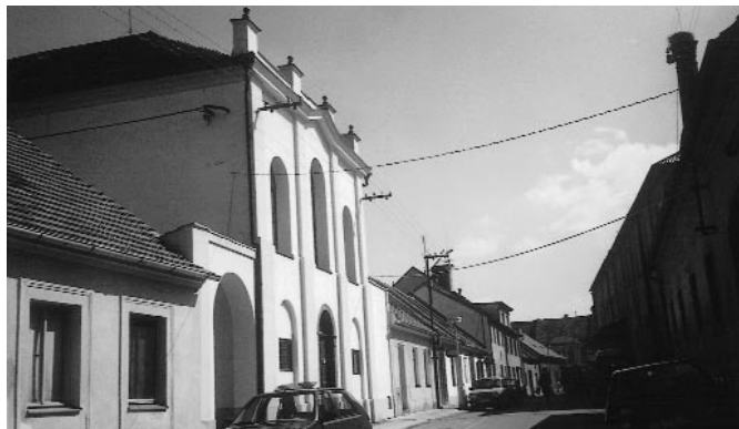
Synagoga v bývalé Židovské ulici ve Vodňanech
