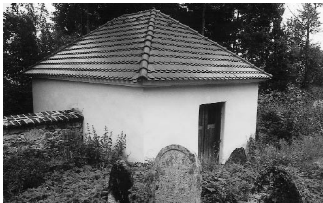
Rekonstruovaná márnice v Čichticích
