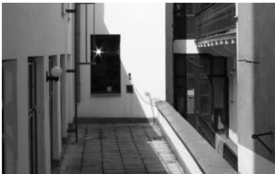
Pohled z okna hotelového pokoje v prvním patře, v kterém v šedesátých letech sídlilo zastoupení egyptských aerolinií. Ze snímku je patrné, že přenesení těla omámeného Charlese Jordana do vedlejšího domu č.17, nebyl žádný problém. Dnes již místnost hotelovým hostům neslouží.
